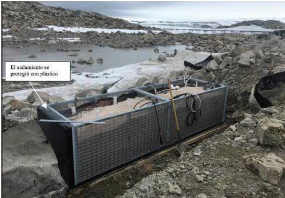
Fotografía 4: Construcción de la puerta de la PRB con "palets-jaula", donde se aprecian los piezómetros (tubos de color blanco) para el control del agua y los medios reactivos secuenciados. El cable de color negro es la cinta calefactora que se conectará.
