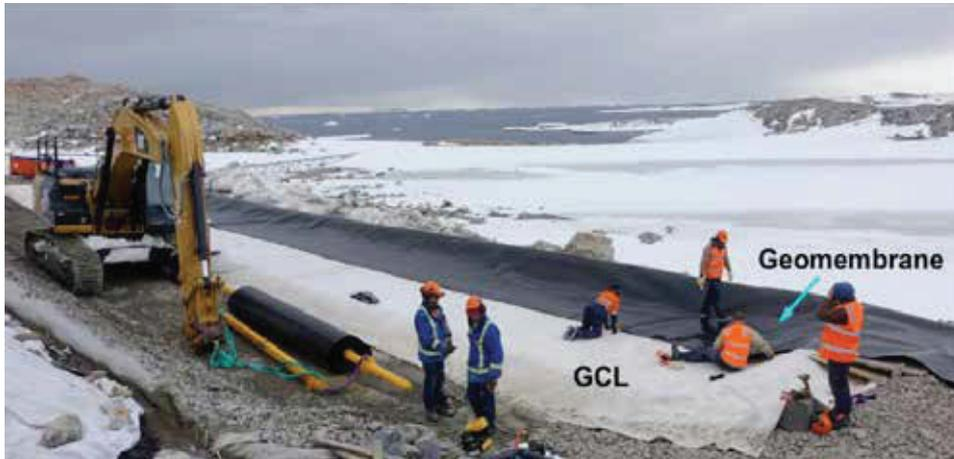
Fotografía 2: Instalación del GCL (de color blanco) y la geomembrana (de color negro)
