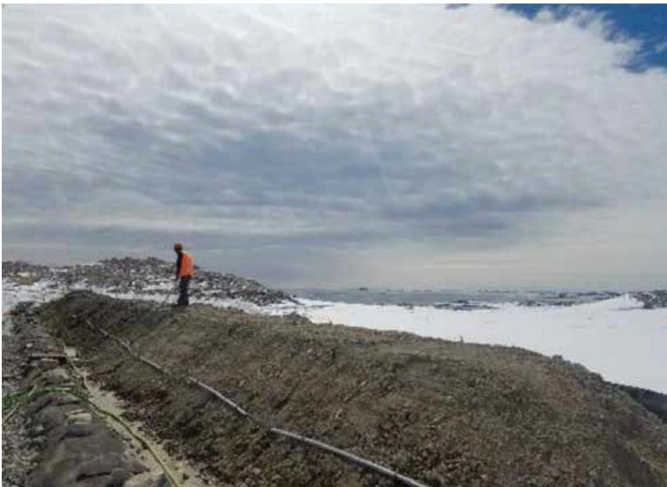
Fotografía 6: Circulación manual del lixiviado de la biopila sobre el suelo durante el verano.
