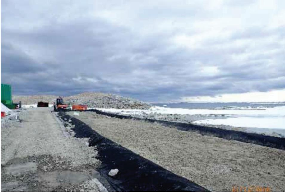
Fotografía 5: Capa protectora de suelo de grano más fino distribuido en la zona de contención de la biopila
