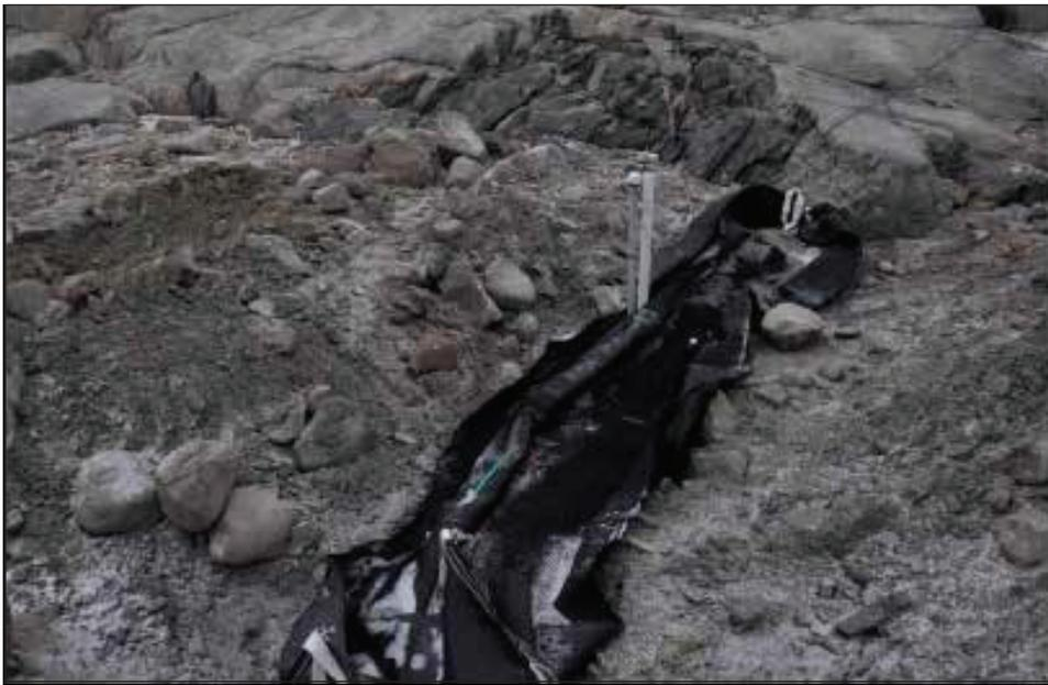
Fotografía 6: Puerta de la PRB instalada con uso de geotubo (tela de color negro). Nota: con las cubiertas superiores de operación cerradas para evitar la dispersión de los medios granulares en el medioambiente.
