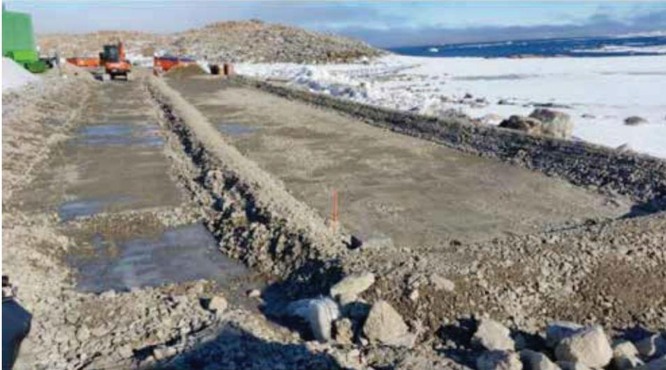
Fotografía 1: Subsuelo de biopila compactado con bermas de tierra antes de la instalación de los demás componentes del sistema de revestimiento de compost (revestimiento geosintético de arcilla, geomembrana y geotejidos).
