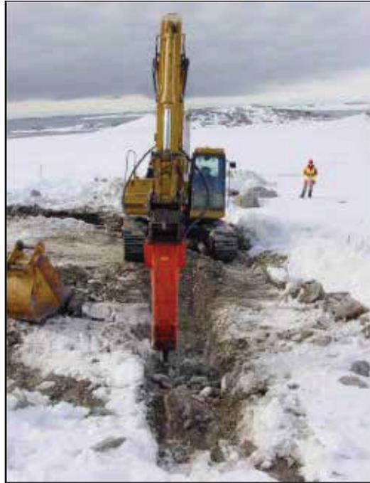
Fotografía 1: Excavación de la zanja para el ala de la PRB en terreno congelado.
