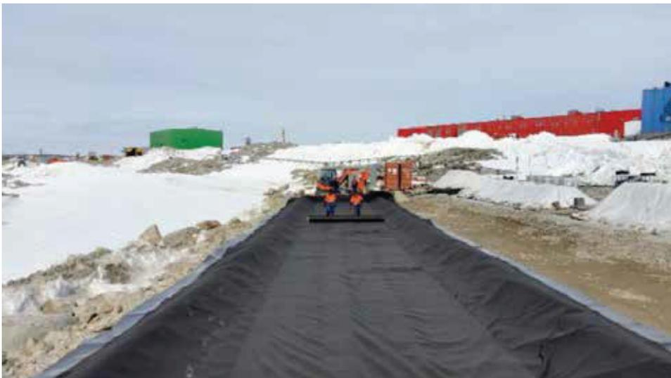
Fotografía 4: Construcción completa del sistema de revestimiento de compost, donde se aprecia el geotextido (de color negro) la membrana superpuesta (de colores negro y gris) y el GCL debajo.
