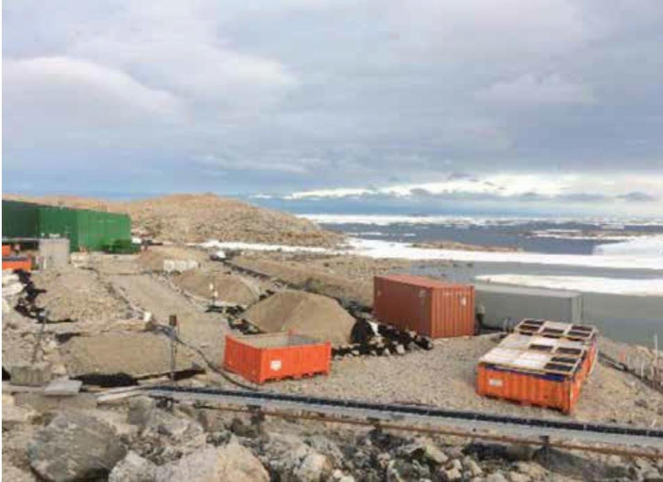
Fotografía 7: Se pueden apreciar varias biopilas construidas en funcionamiento. Téngase presente que una de ellas está descubierta para la extracción de muestras.
