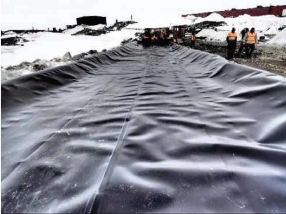
Fotografía 3: Geomembrana (de color negro) instalada sobre el GCL y las bermas. Téngase presente que la costura con sellado térmico corre por el centro de la geomembrana y muestra ambos paneles unidos.
